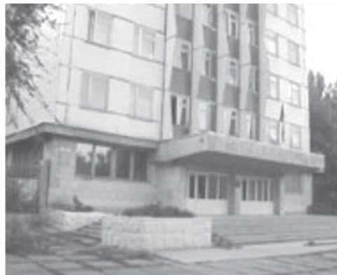
Instituția Medico-Sanitară Publică Institutul de Cercetări Științifice în Domeniul Ocrotirii Sănătății Mamei și Copilului. Blocul administrativ
